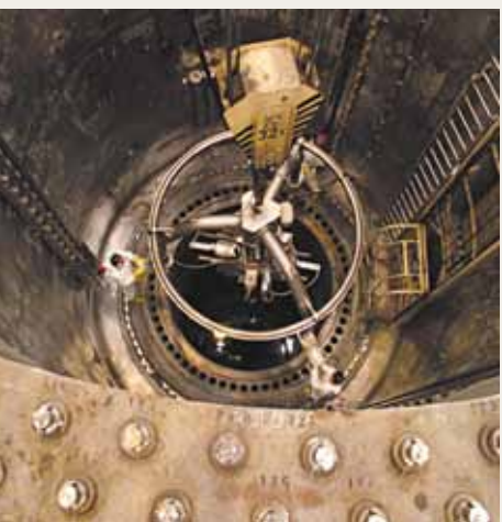
A manipulátor tartályba helyezése
