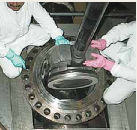
A főelzáró tolózár osztósíkjának ellenőrzése
